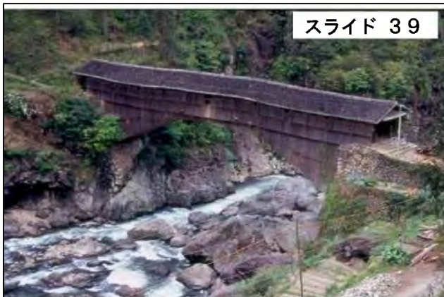
鸾峰桥，在福建寿宁下党村水尾，始建不详，今桥建于嘉庆五年（1800）、1963年修。单孔净跨34米，宽5米，全长47.6米。
