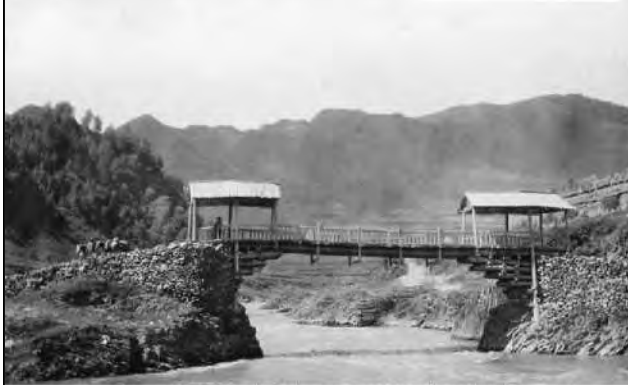
1911年摄甘肃岷州与卓尼交界处叠涩木梁桥 16
