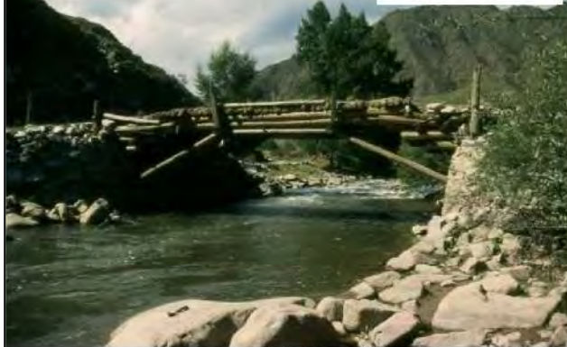
甘肃夏河叠涩木梁加八字撑架桥 18
