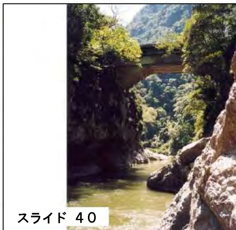
鸾峰桥，在福建寿宁下党村水尾，始建不详，今桥建于嘉庆五年（1800）、1963年修。单孔净跨34米，宽5米，全长47.6米。
