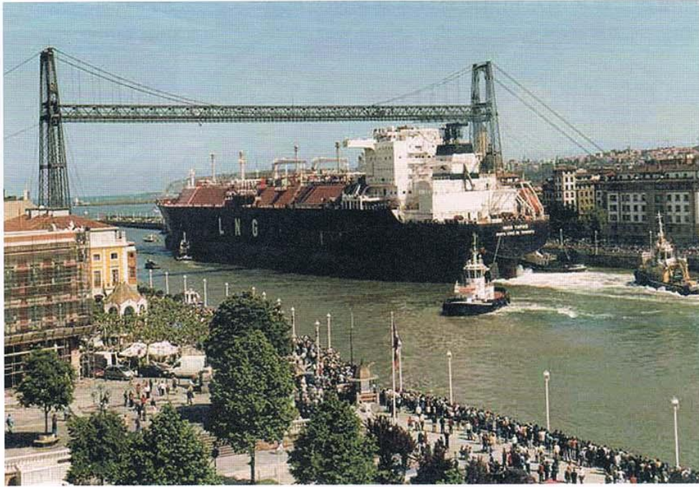
海上交通のため高い橋桁と長い径間
