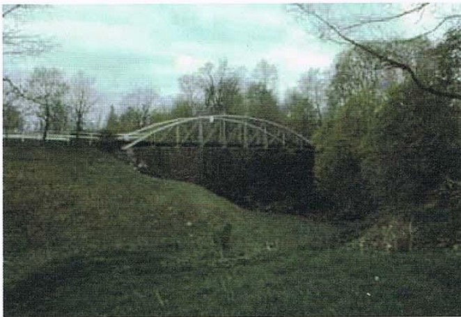
スライド 13 ホイップルの鉄製 ボーストリングトラス橋 (1867年建設)
