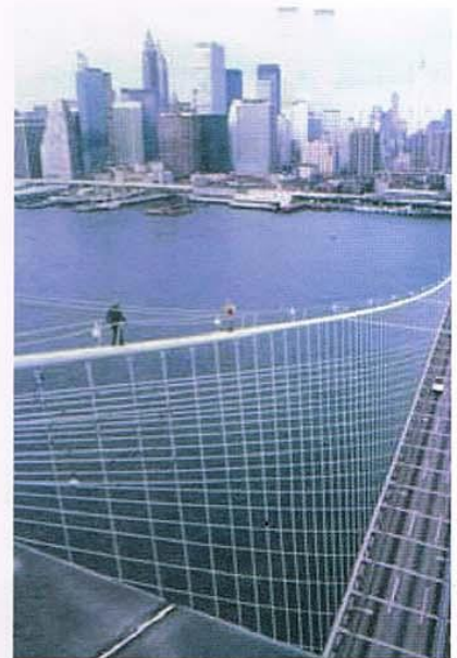
スライド 3 ブルックリン橋 (1883 年)
