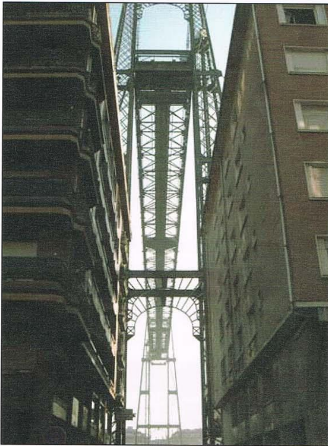
吊り桁は1941年に再建された際に、もとより少し高くなっている
