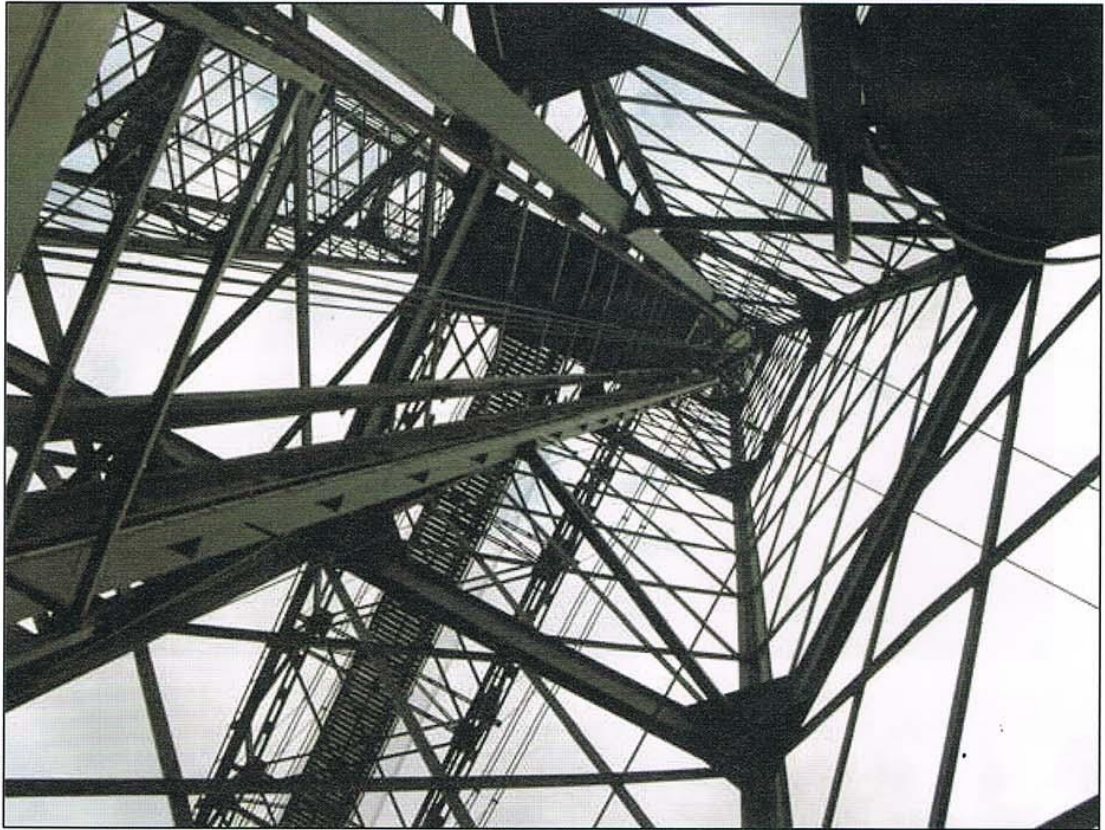
橋脚の内部構造
