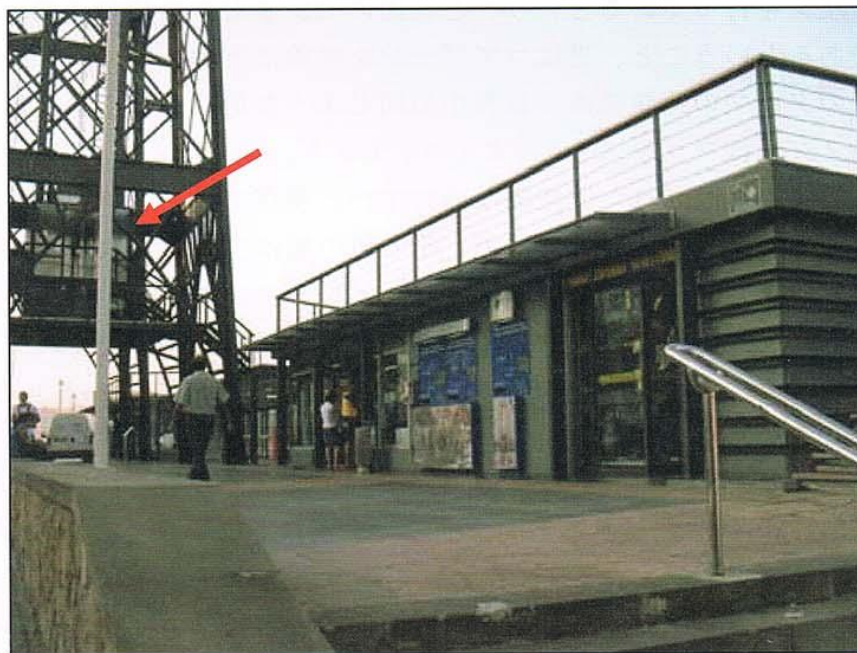
橋脚内部のエレベーター
