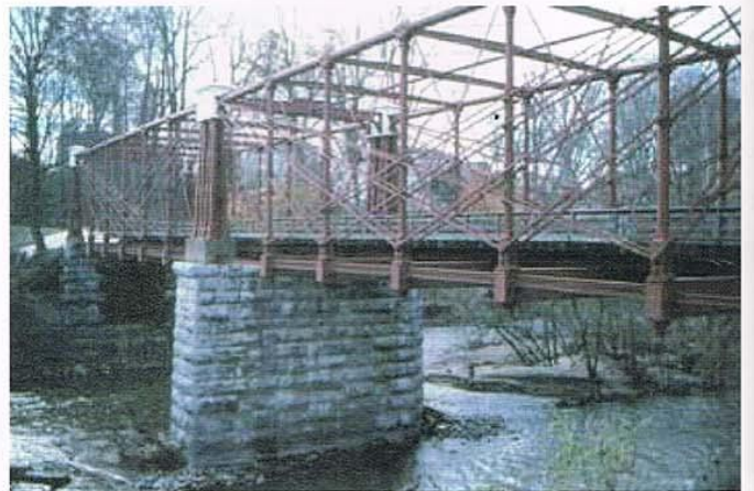
スライド 46 ボルティモア・オハイオ 鉄道のボールマントラス橋(1869 年)
