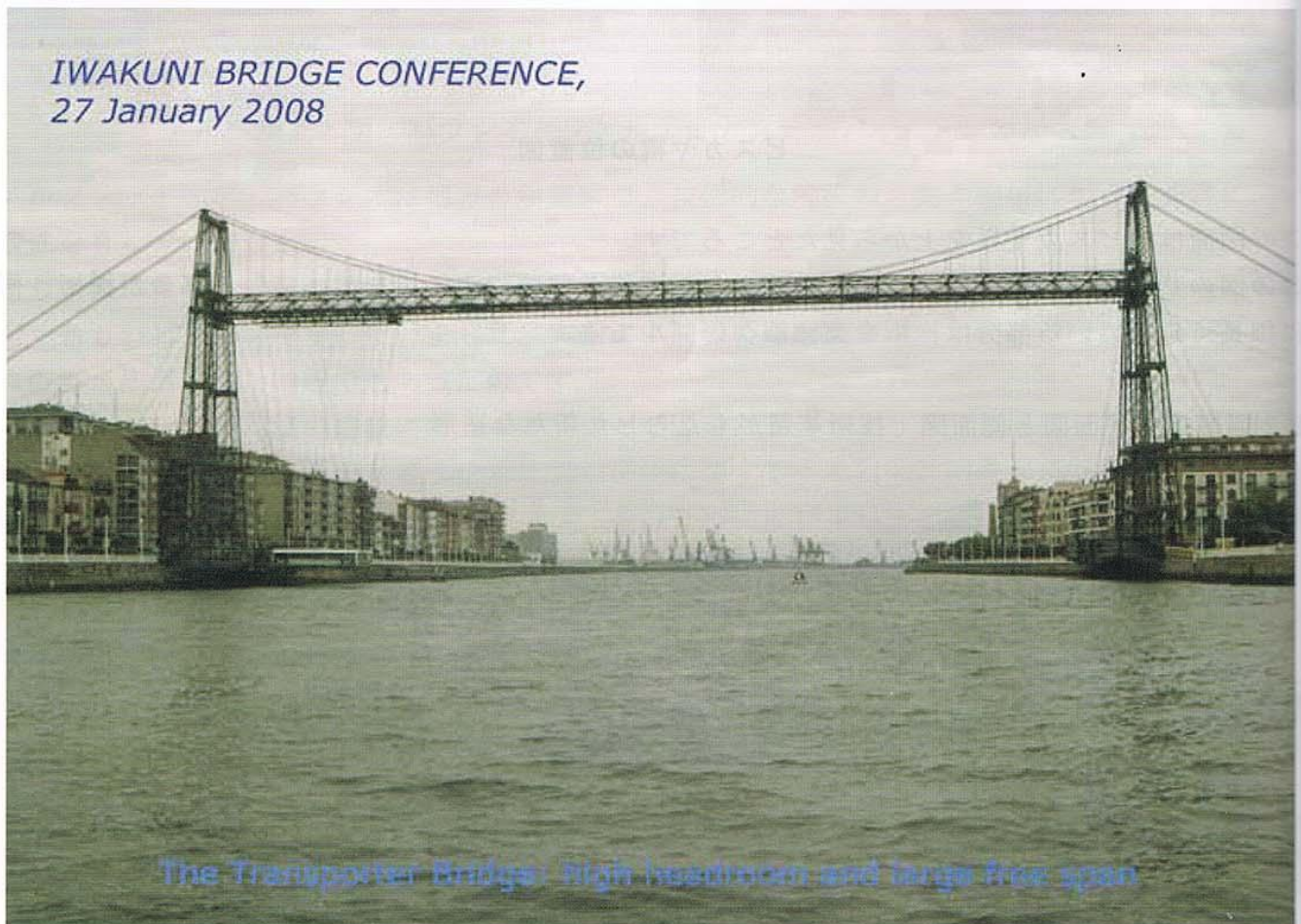
運搬橋：高い桁高と長い径間
