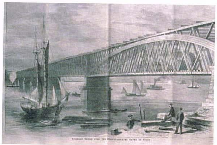
スライド 36 サスケハナ川の木鉄混合橋 (1867年建設)
