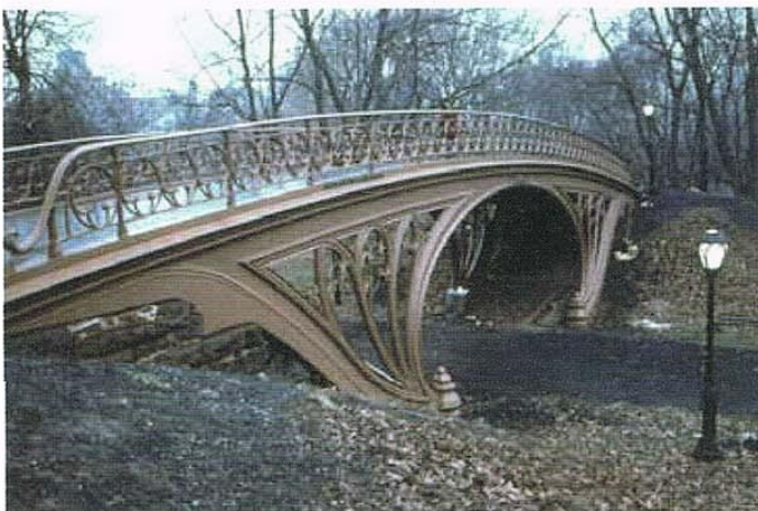
スライド 15 セントラルパークのゴシックアーチ ボーストリングトラス橋 (1867年建設)
