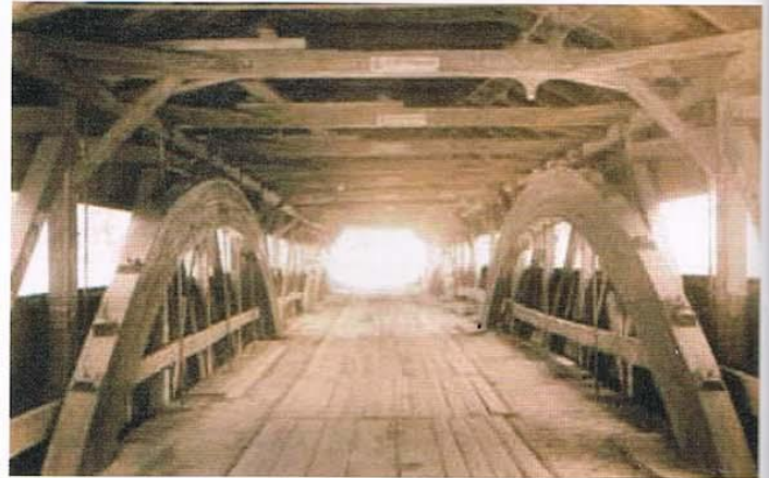
スライド 29 バーのアーチトラス内部
