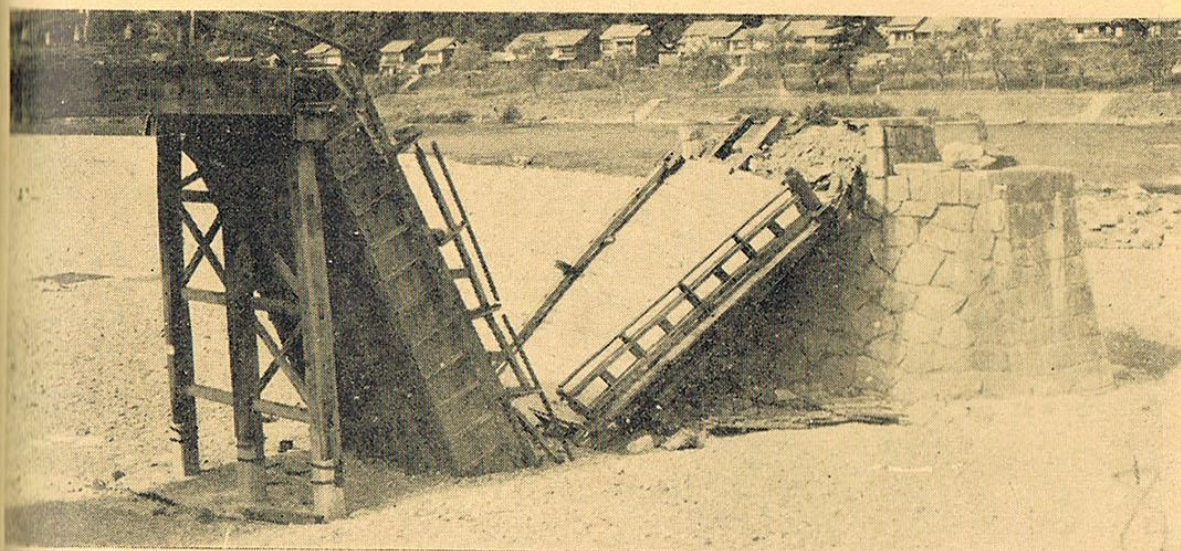
第一橋、脚を奪われて折断、 墜前の惨状
