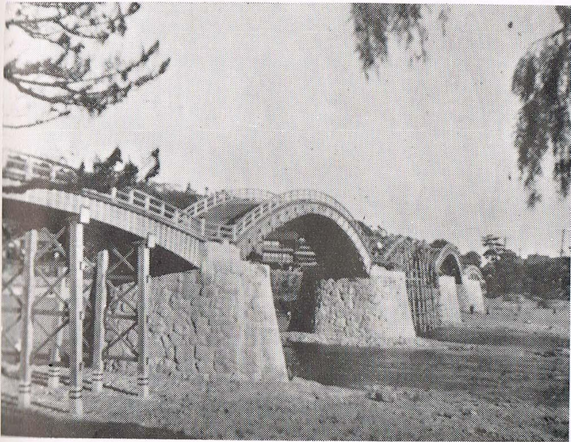
第 五 橋 工 事 着 手
