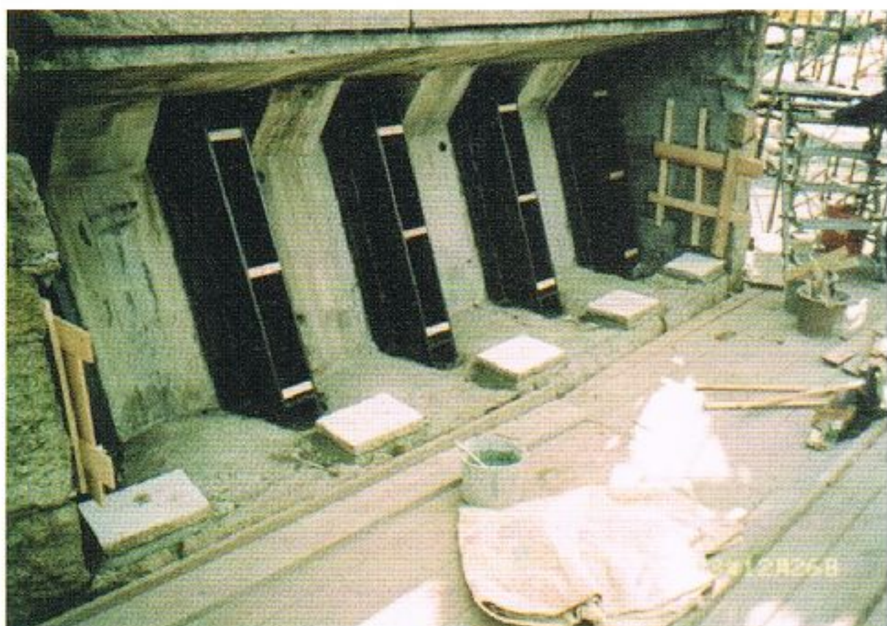
写真 6.7-31 沓鉄状況，敷並石据付(岩国市撮影)
