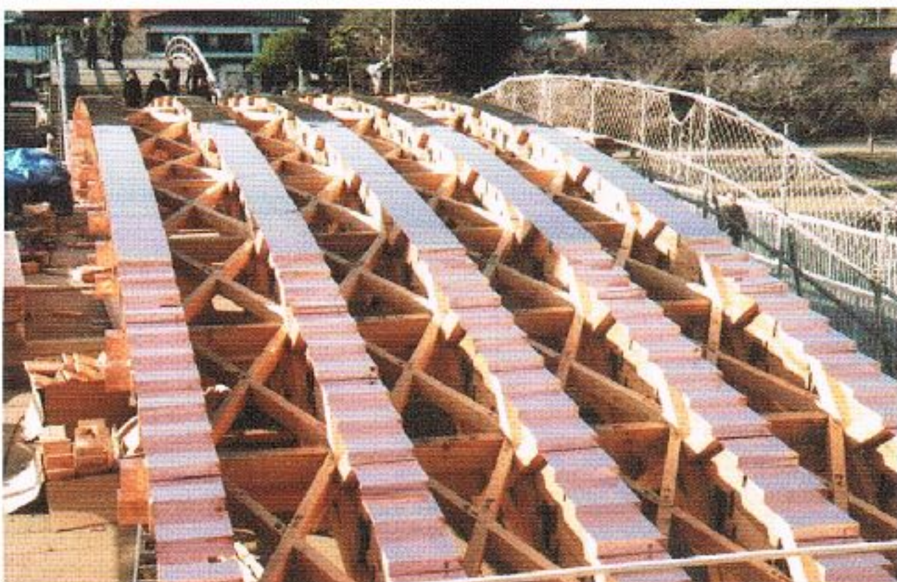
写真 6.7-63 反橋平均木上銅板施工 (岩国市撮影)
