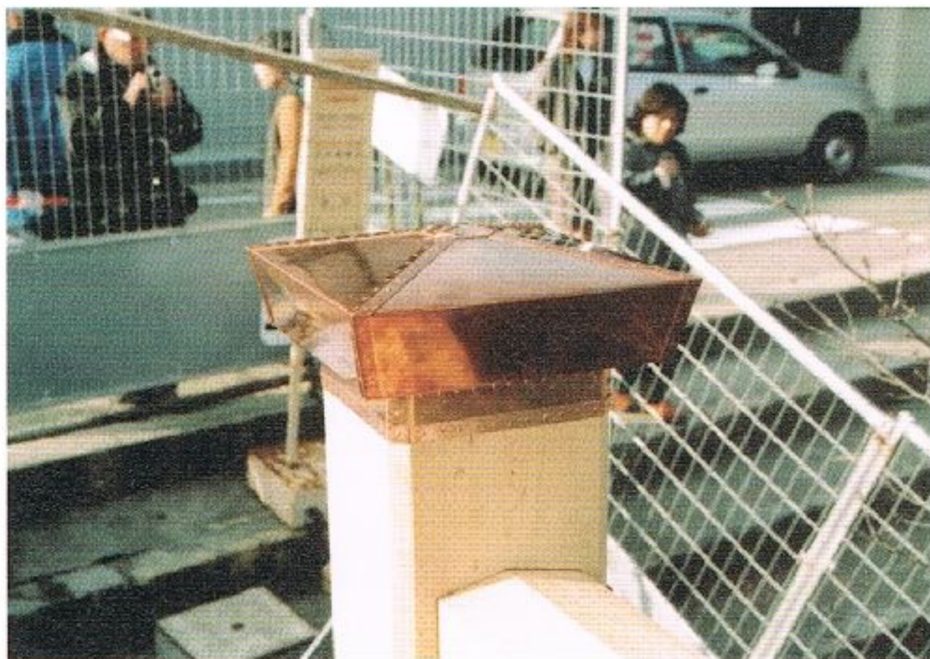
写真 6.7-65 袖柱笠木銅板(新設, 岩国市撮影)
