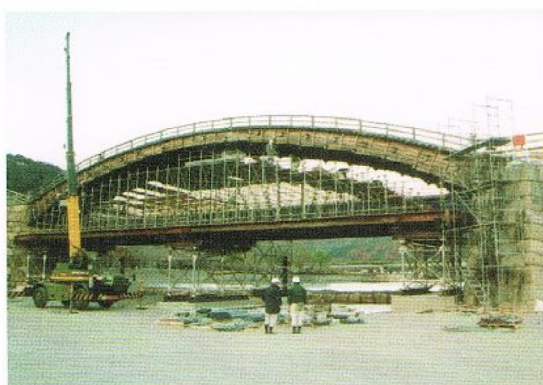
写真 6.7-24 支保工設置状況(岩国市撮影)
