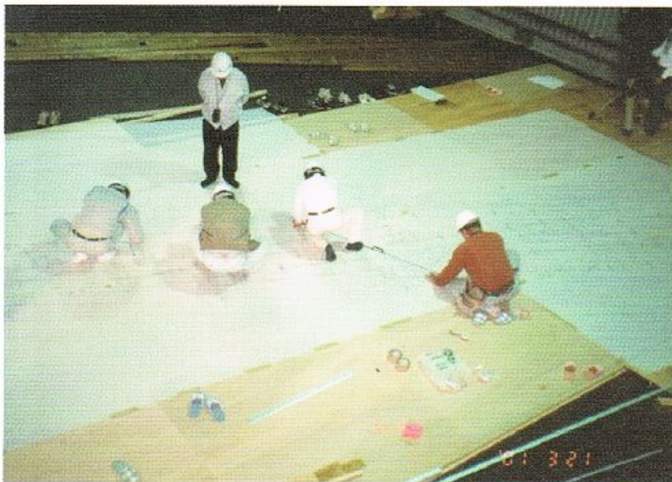
写真 6.7-3 現寸図フィルム転写(岩国市撮影)
