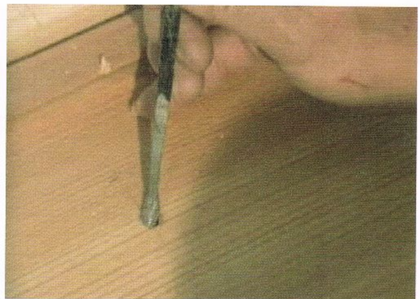
写真 6.7-70 橋板止釘(皆折釘)先端 シーリング塗布(岩国市撮影)
