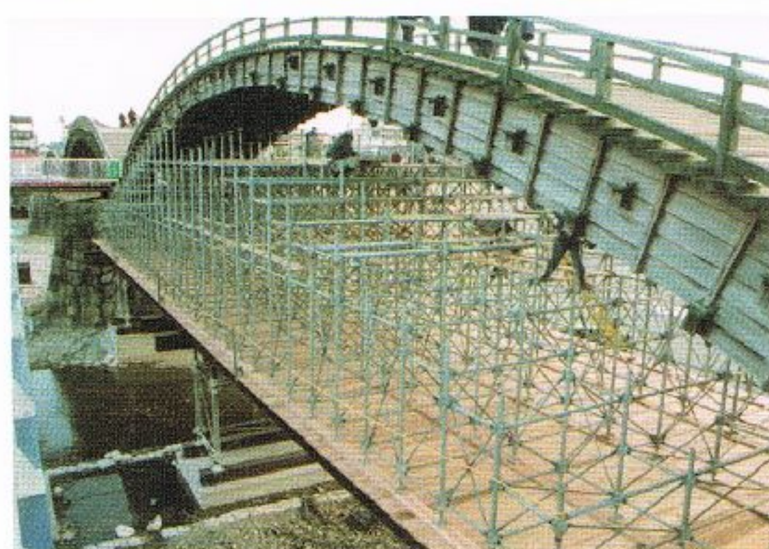
写真 6.7-25 パイプサポートシステム組立 (岩国市撮影)
