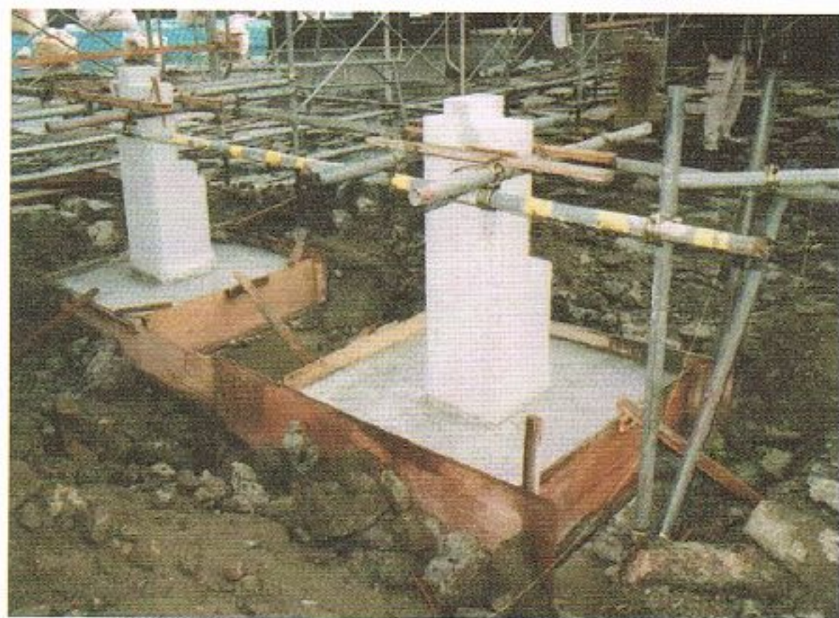
写真 6.7-54 橋杭受石据付(岩国市撮影)
