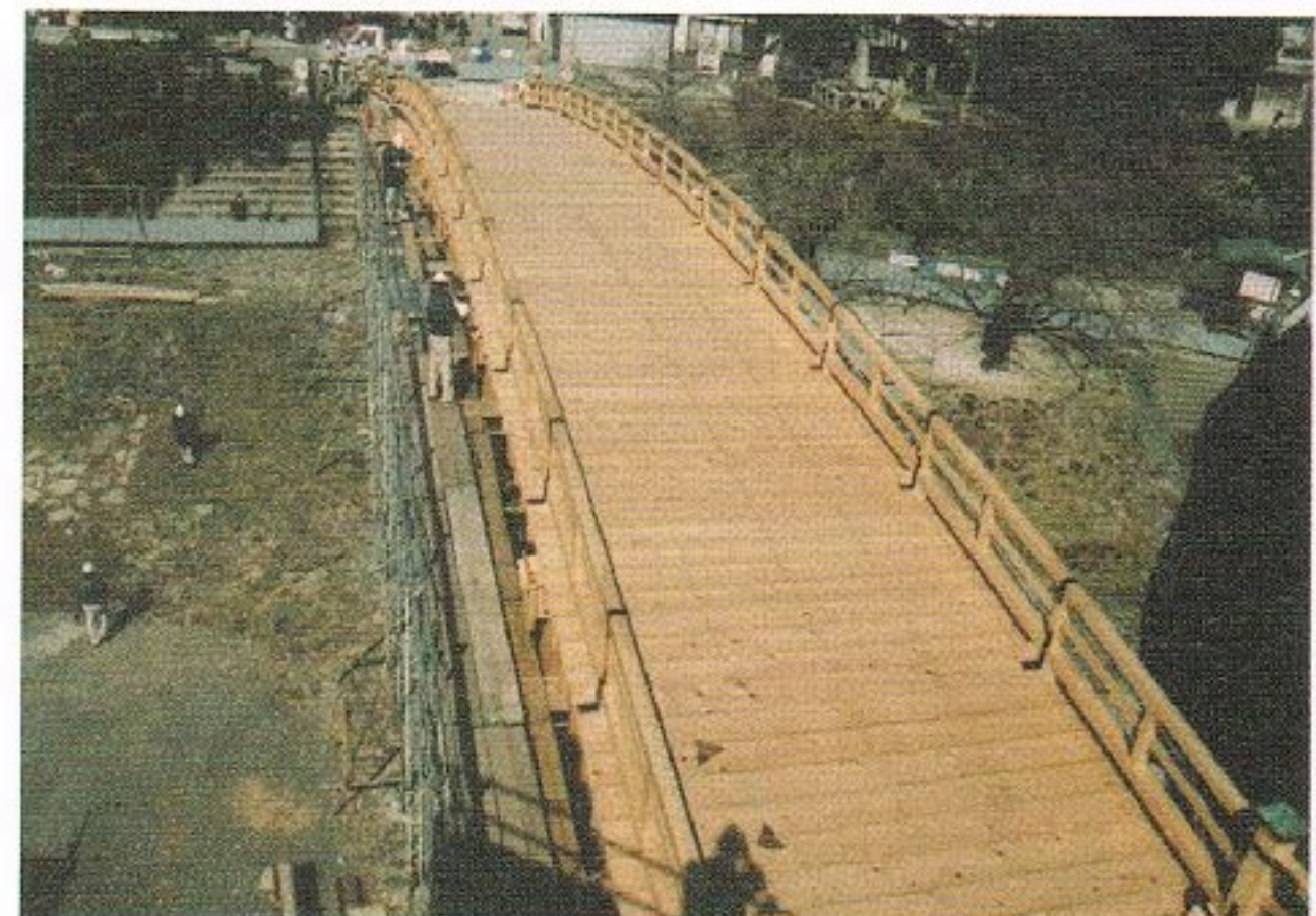
写真 6.7-52 柱橋完成(岩国市撮影)
