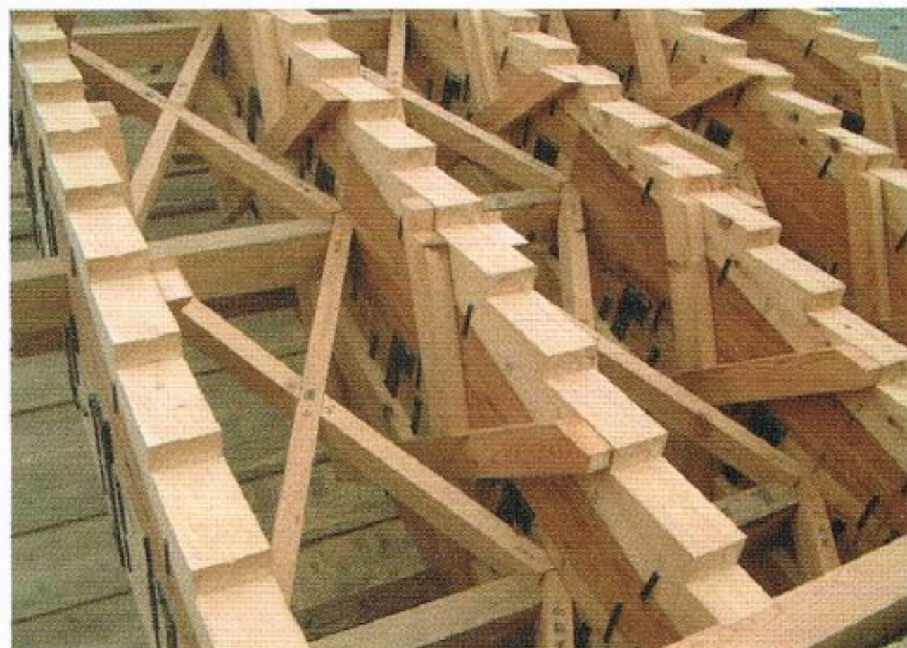
写真 6.7-42 鞍木・助木・振止木取付 (岩国市撮影)
