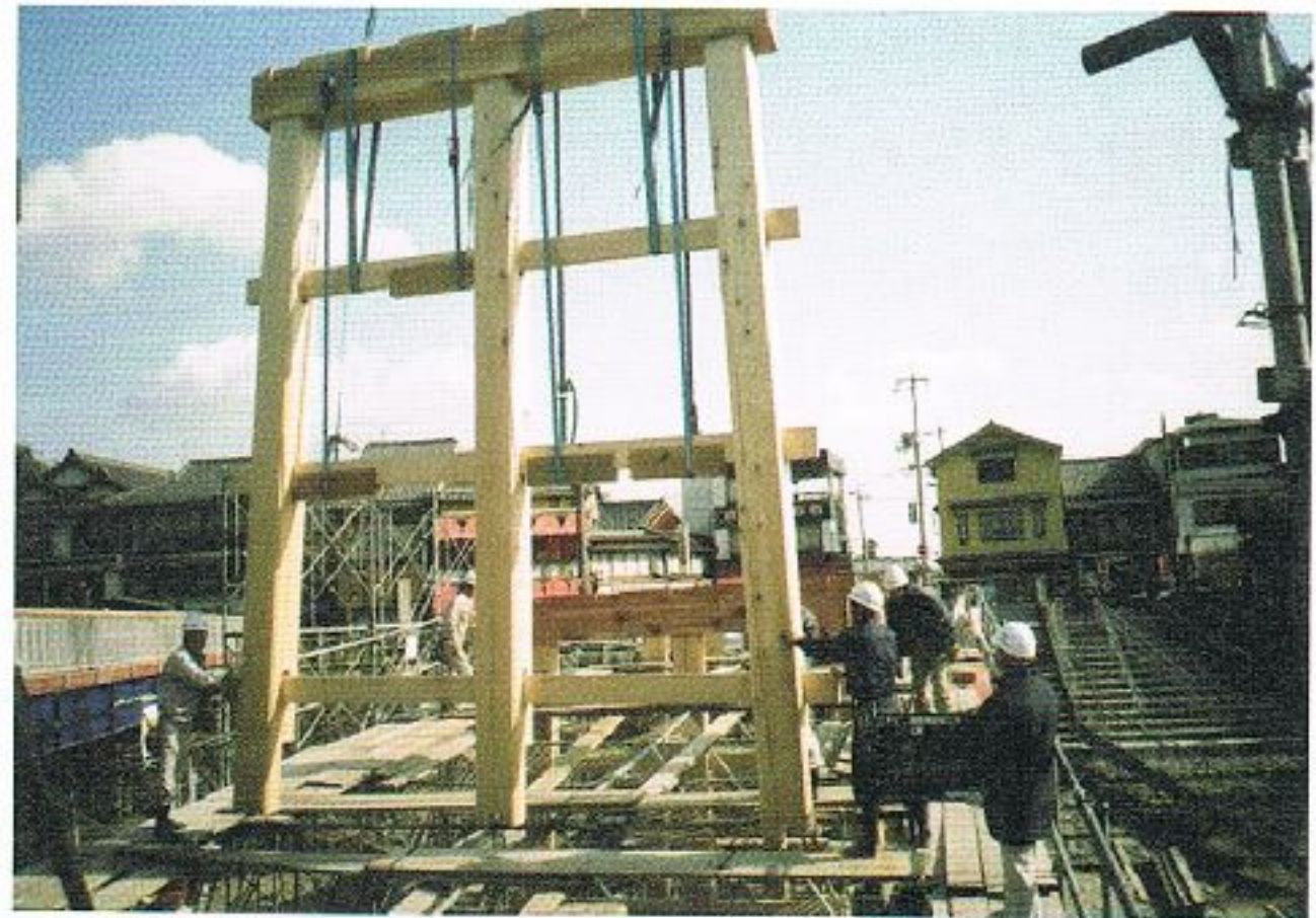
写真 6.7-50 橋杭吊り込み(岩国市撮影)
