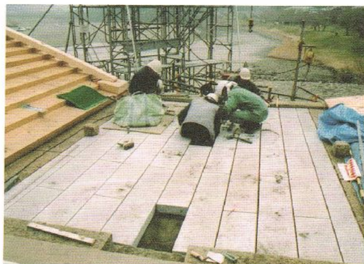
写真 6.7-56 橋台・橋脚天端敷石施工 (岩国市撮影)
