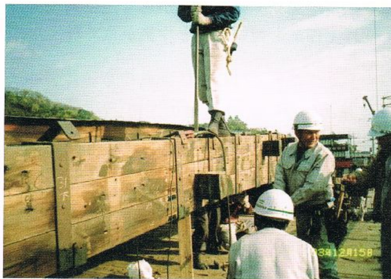
写真 6.7-28 第三期工事反橋手バラシ解体状況 (岩国市撮影)
