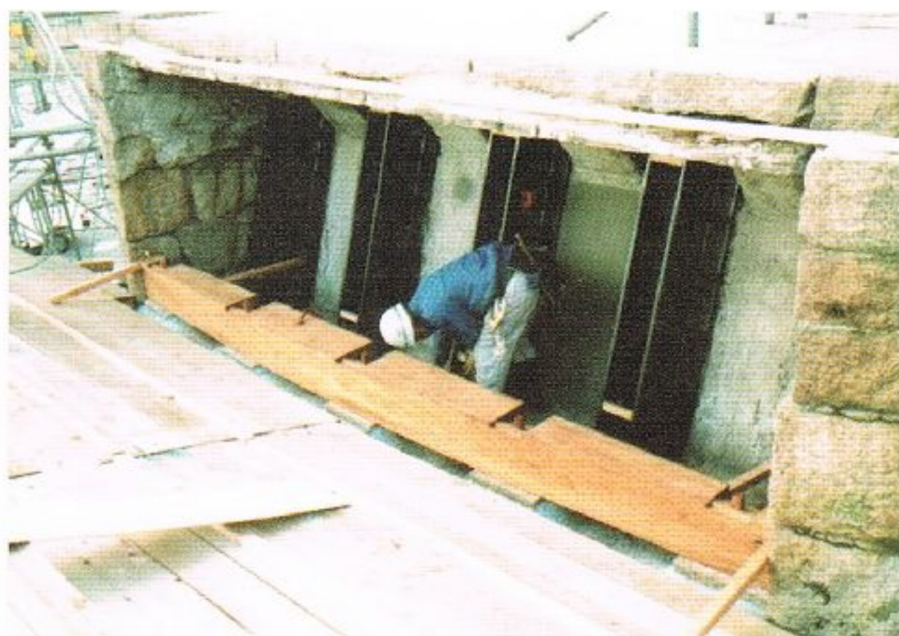
写真 6.7-32 敷梁据付(岩国市撮影)
