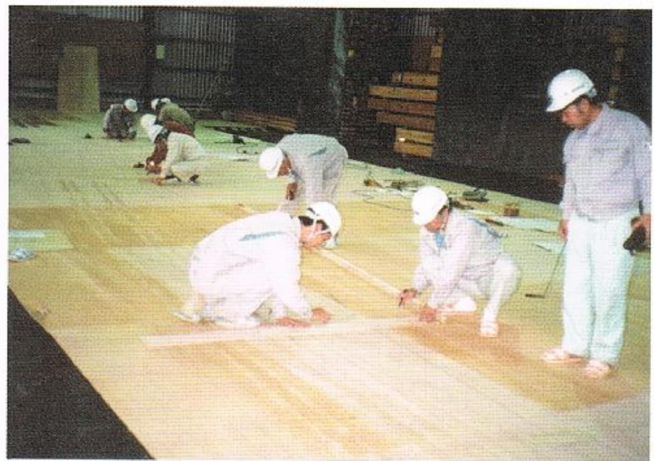
写真 6.7-2 柱橋現寸図作図状況(岩国市撮影)
