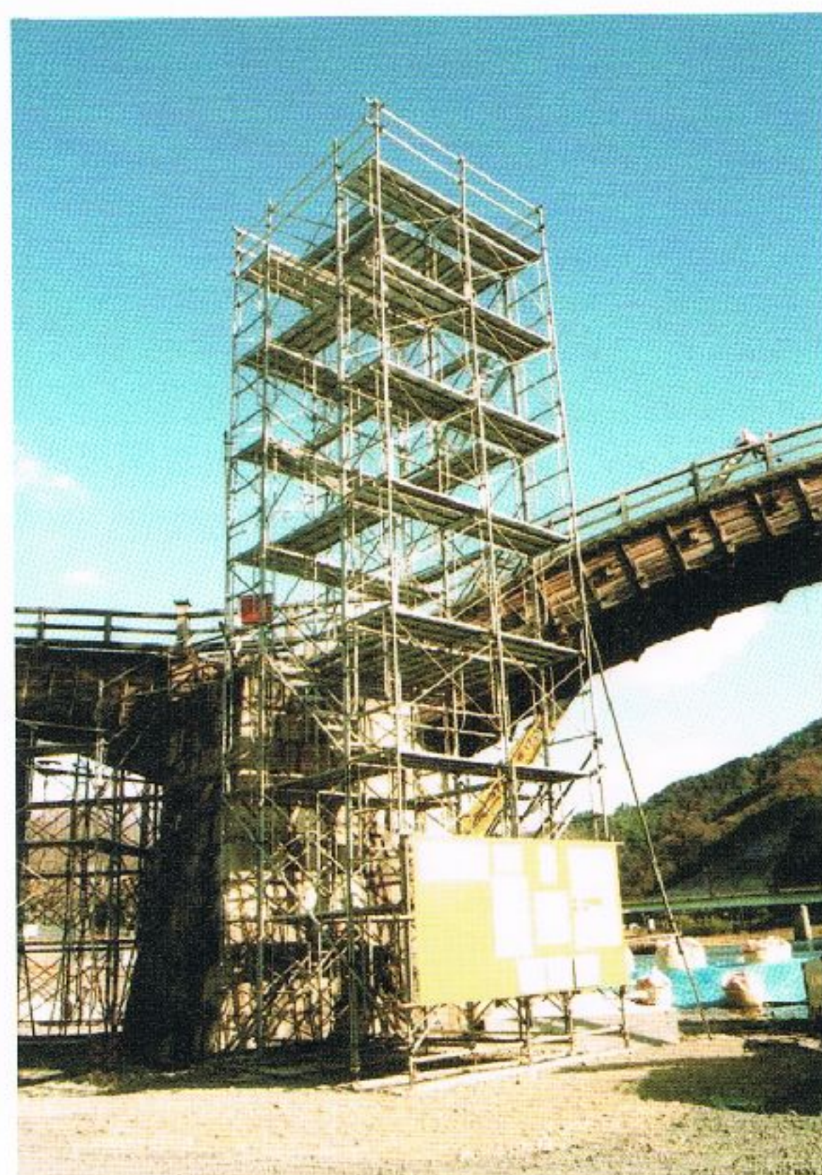
写真 6.7-26 昇降タワー設置(岩国市撮影)
