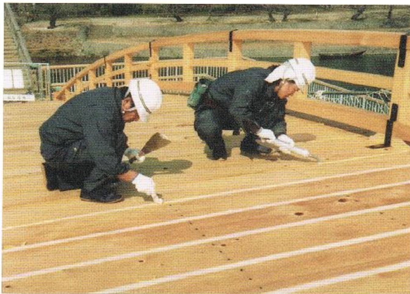
写真 6.7-69 橋板継目シーリング充填施工 (岩国市撮影)
