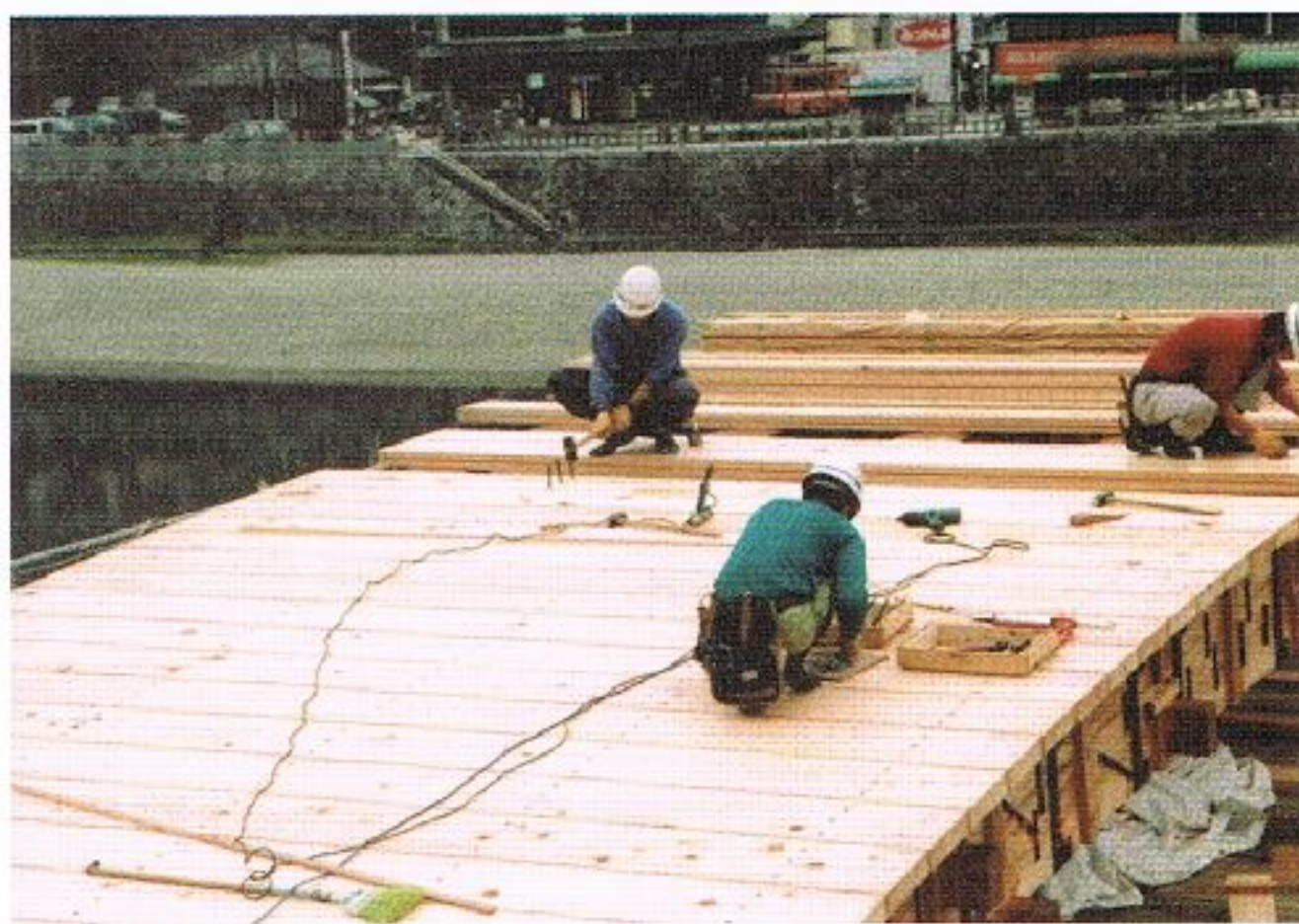
写真 6.7-44 橋板(敷板)張り(岩国市撮影)
