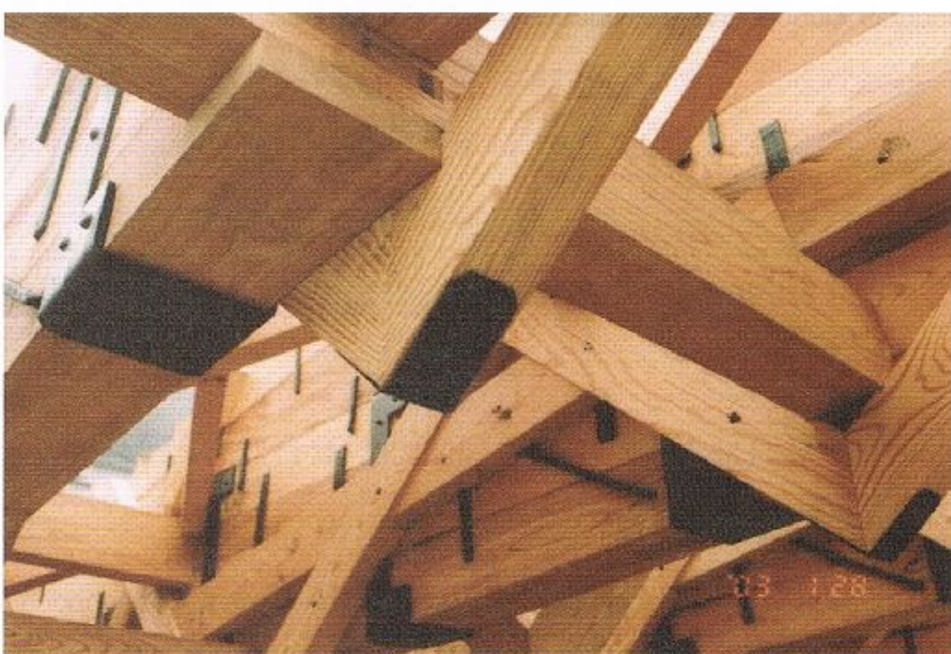
写真 6.7-62 鞍木巻金取付(岩国市撮影)
