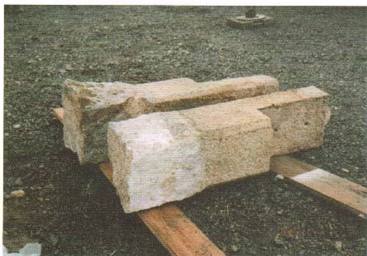
写真 6.7-53 既設受石撤去(岩国市撮影)
