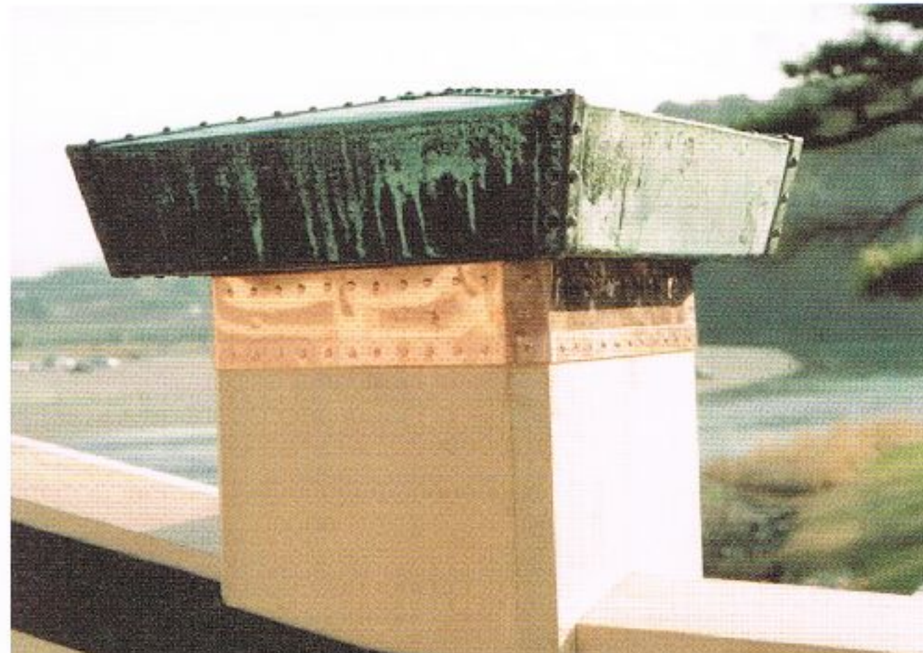
写真 6.7-66 親柱笠木銅板(再利用, 岩国市撮影)
