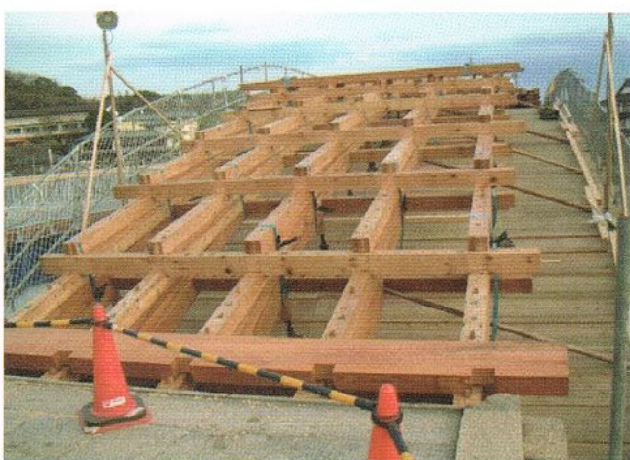
写真 6.7-36 桁組状況(後梁，岩国市撮影)
