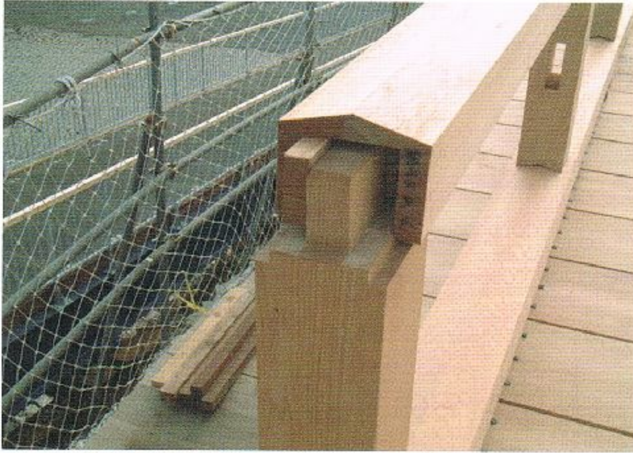
写真 6.7-47 高欄笠木・斗束仕口部 (岩国市撮影)
