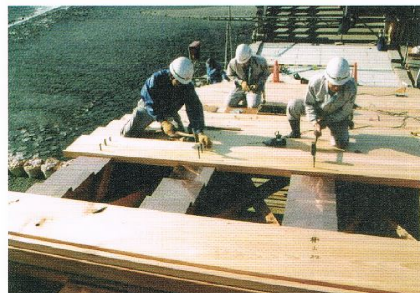
写真 6.7-43 橋板(段板)張り(岩国市撮影)
