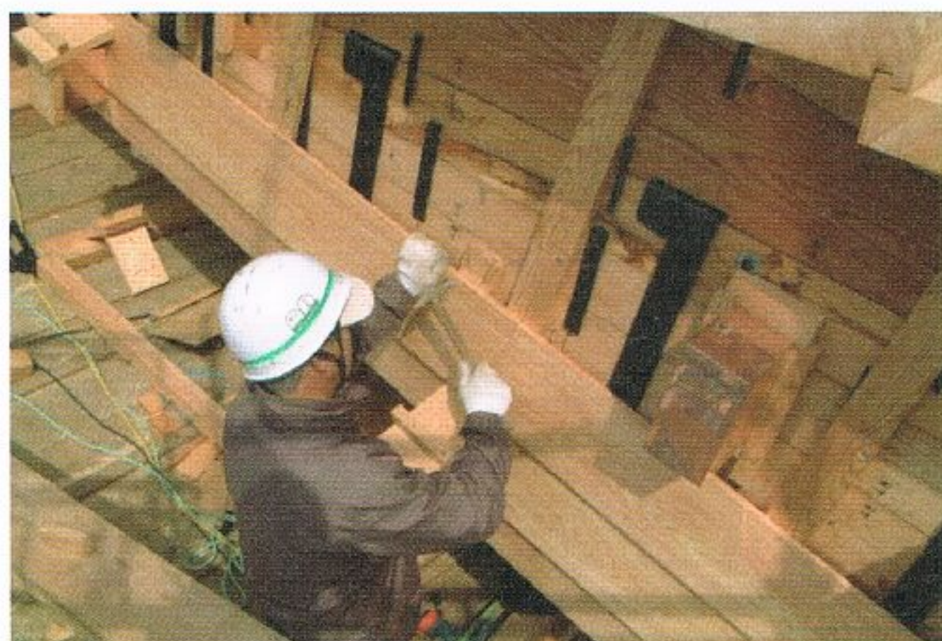
写真 6.7-45 部板取付(岩国市撮影)
