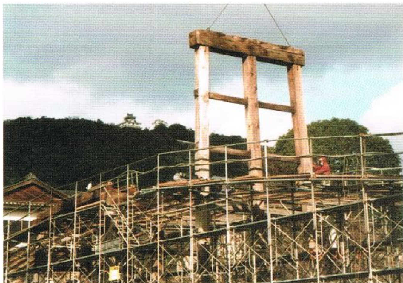
写真 6.7-29 柱橋解体状況(岩国市撮影)
