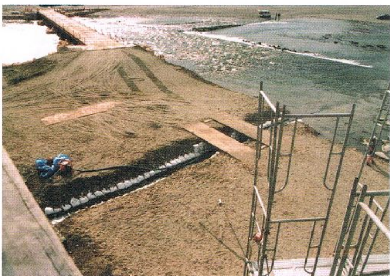
写真 6.7-18 第二期工事作業ヤード(岩国市撮影)
