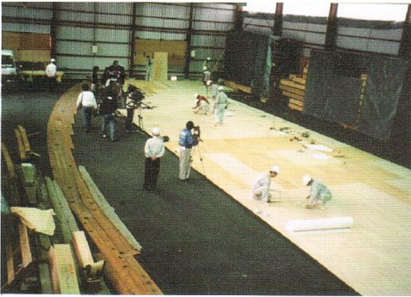
写真 6.7-1 反橋現寸図作図状況(岩国市撮影)
