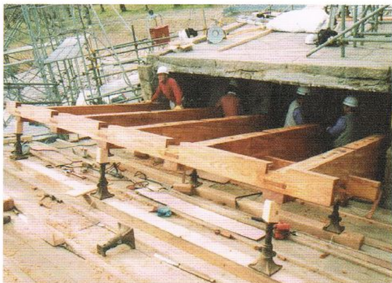
写真 6.7-34 鼻梁取付(岩国市撮影)
