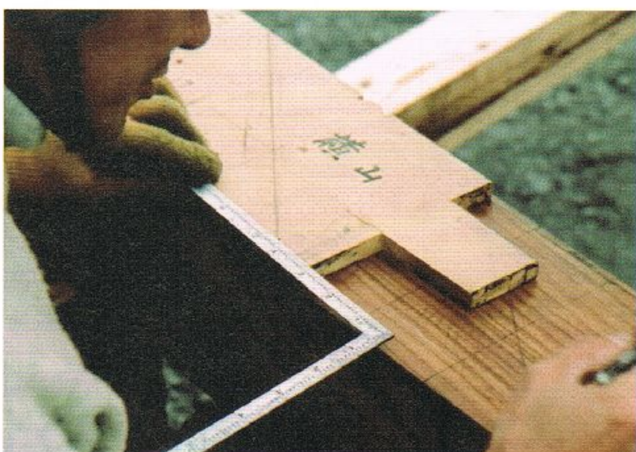
写真 6.7-38 大棟木継手現地加工(岩国市撮影)
