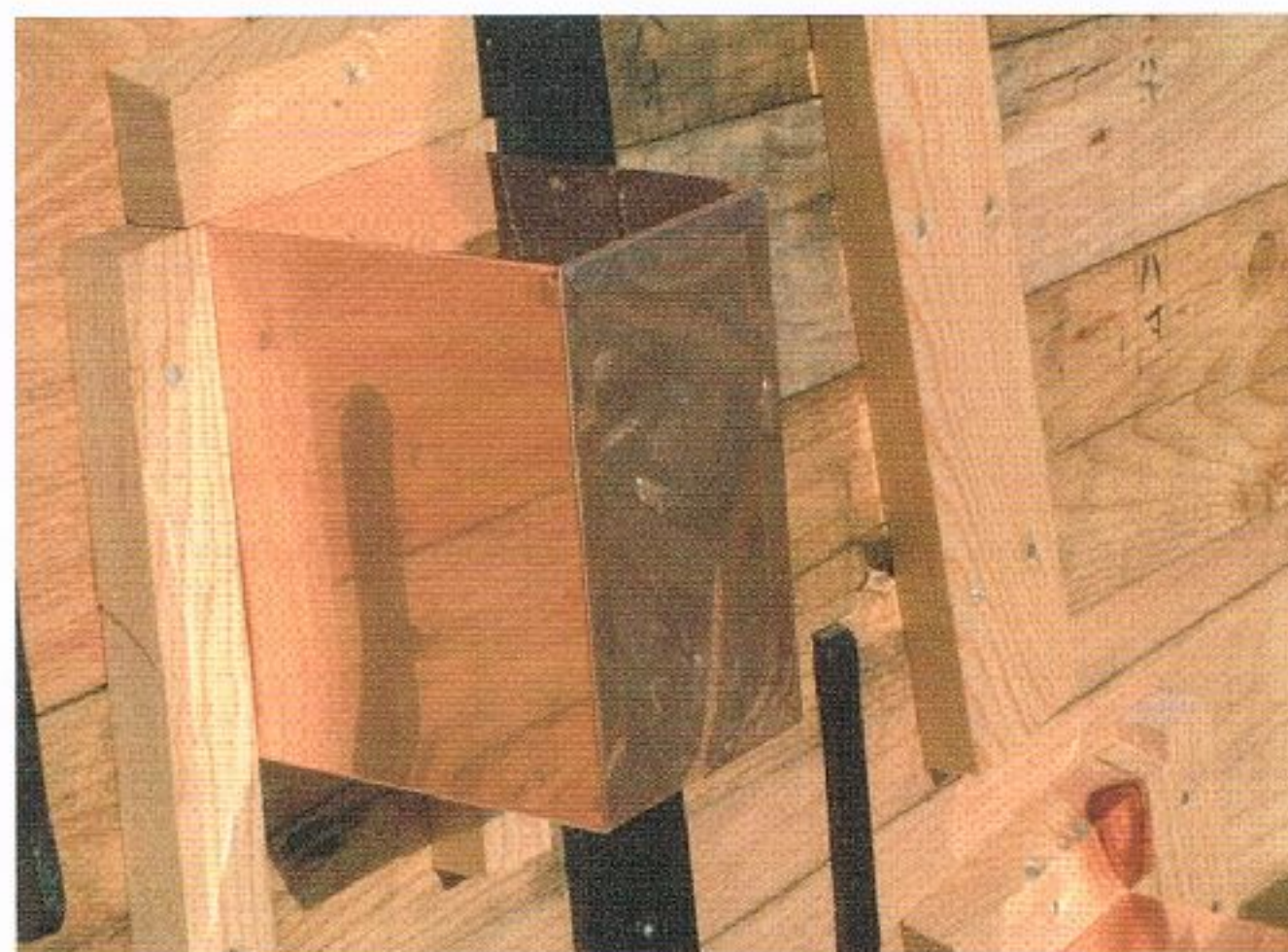
写真 6.7-68 梁鼻銅板(岩国市撮影)
