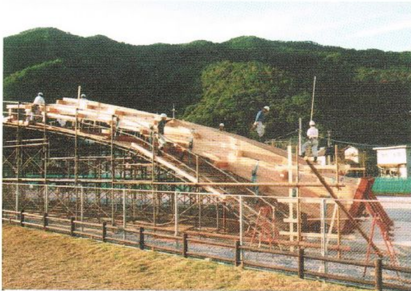
写真 6.7-9 陸組作業状況 1(岩国市撮影)
