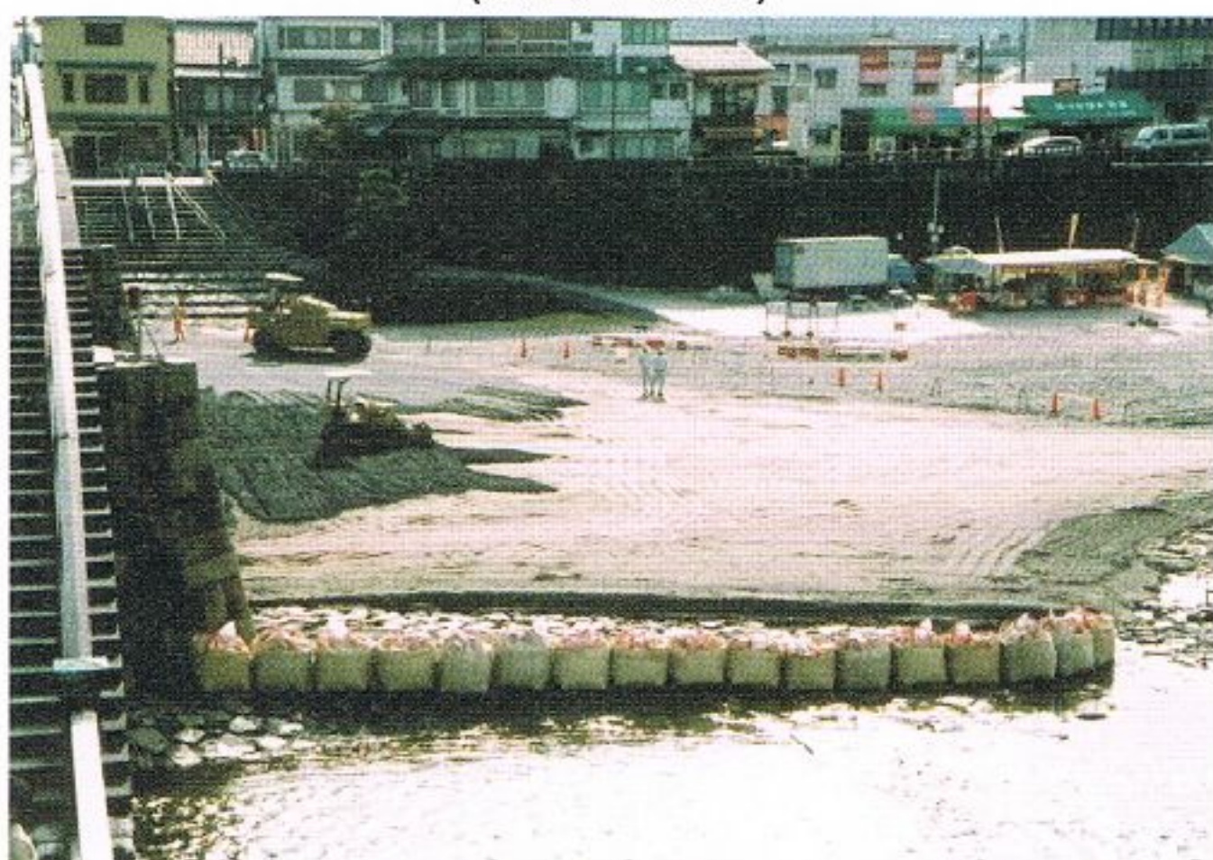
写真 6.7-19 第三期工事作業ヤード(岩国市撮影)
