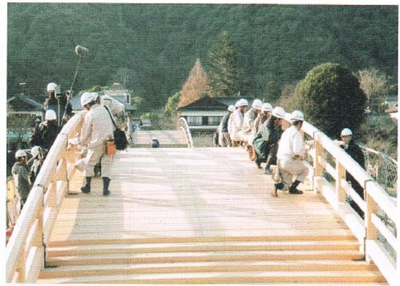
写真 6.7-48 高欄金具取付(岩国市撮影)
