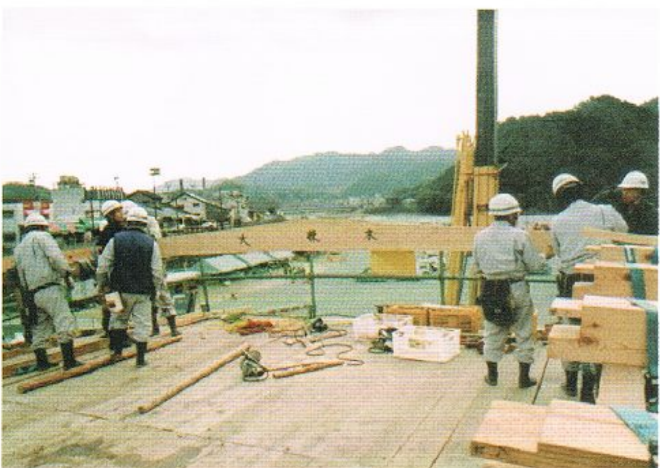
写真 6.7-37 大棟木現地採寸(岩国市撮影)
