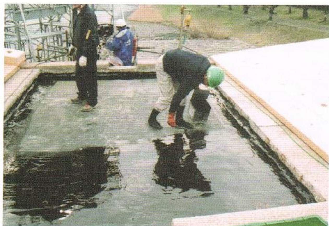
写真 6.7-55 橋台・橋脚天端 タールウレタン塗膜防水(岩国市撮影)
