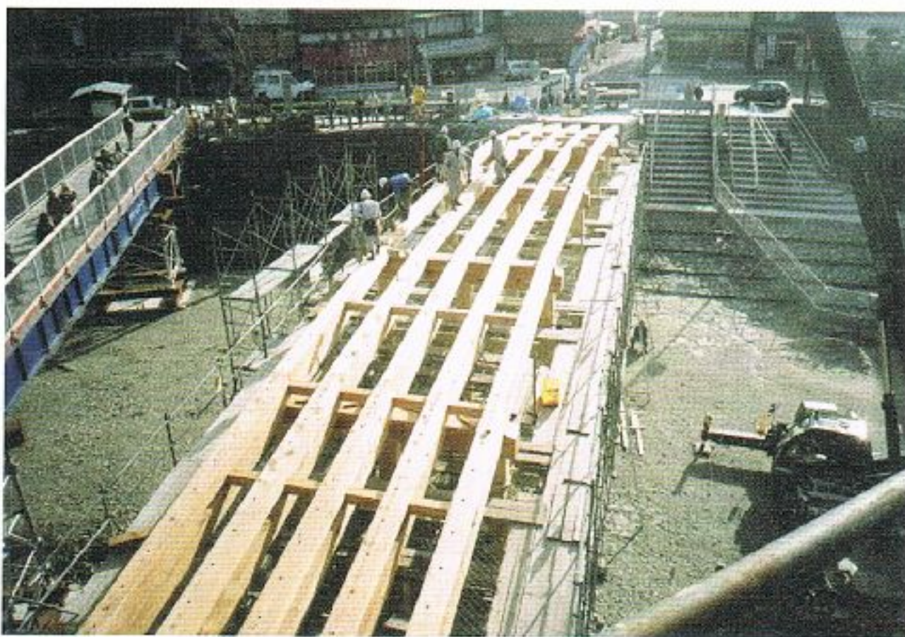
写真 6.7-51 柱橋桁組完了(岩国市撮影)
