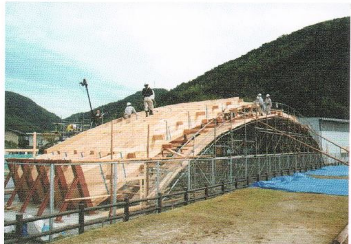
写真 6.7-10 陸組作業状況 2(岩国市撮影)
