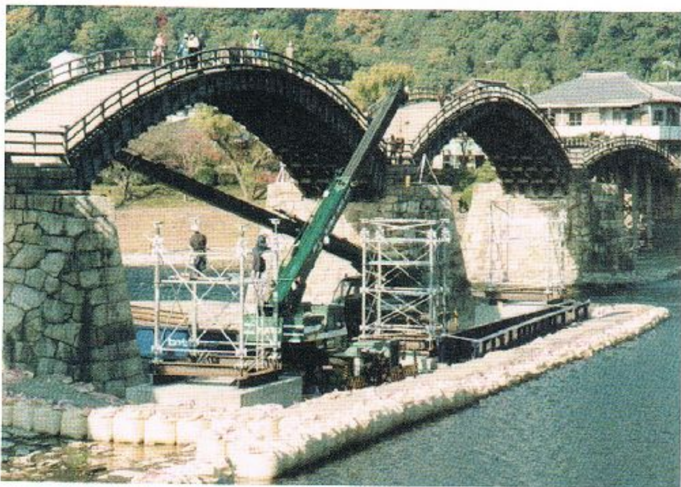
写真 6.7-20 迂回路設置作業中(岩国市撮影)
