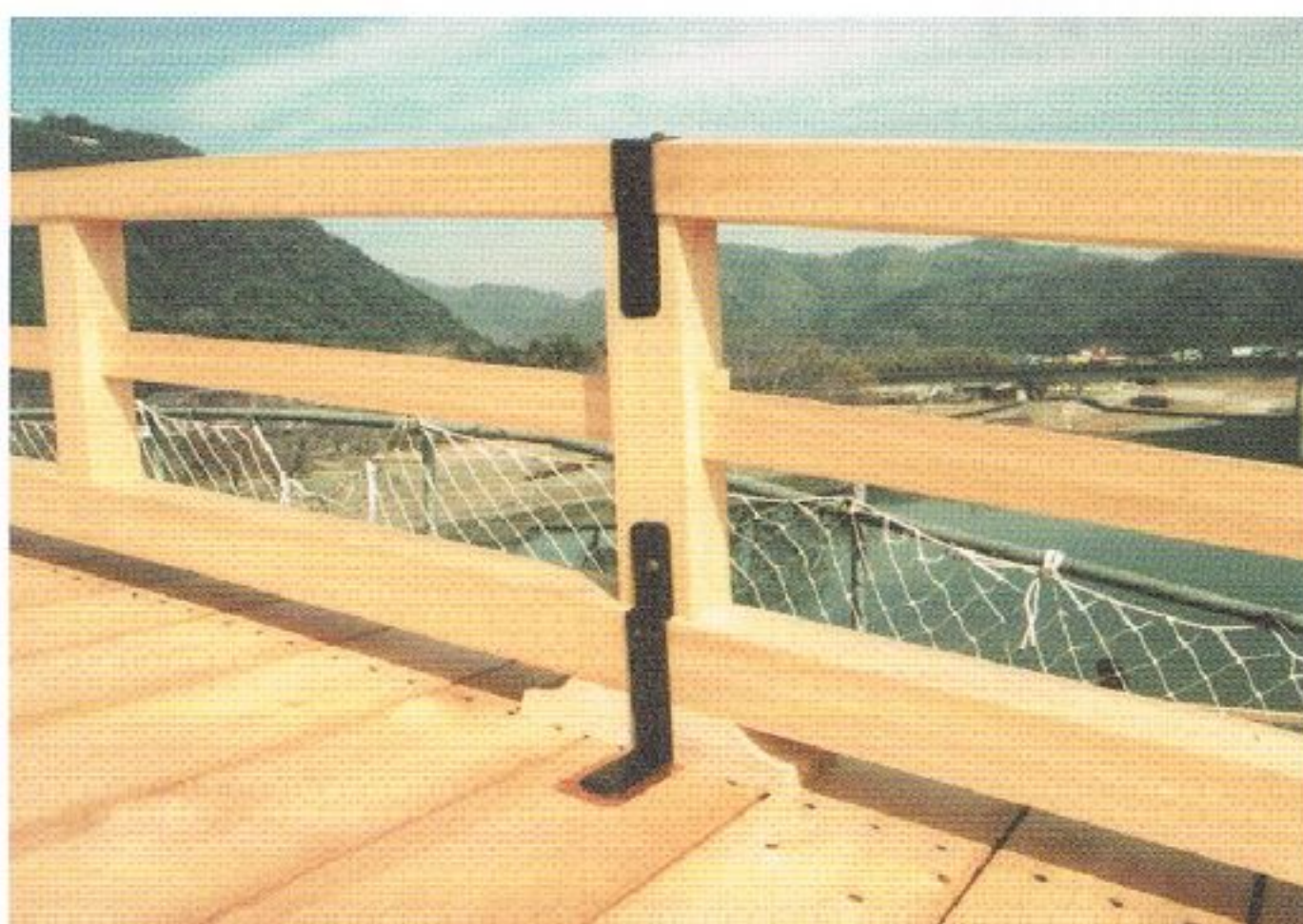
写真 6.7-60 兜金(上)力金取付(岩国市撮影)
