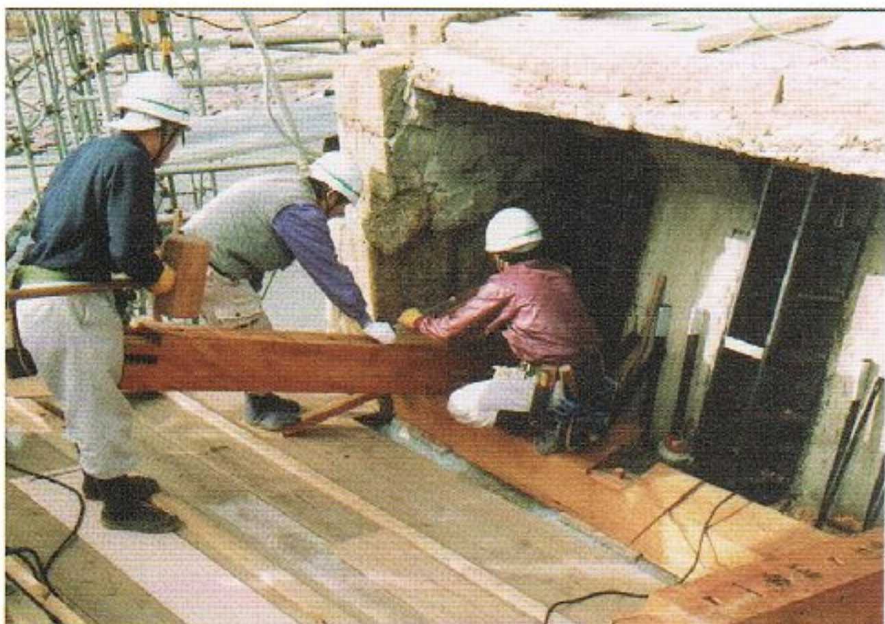
写真 6.7-33 1番桁据付(角度調整，岩国市撮影)
